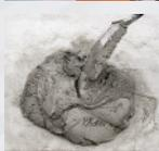
**Preparación del mortero;** prepare el mortero de pega. El mortero puede ser premezclado en seco o hecho en obra. Si utiliza mortero premezclado en seco prepárelo según las instrucciones del fabricante. El mortero hecho en obra, regularmente se prepara en proporción 1:3 de cemento portland: arena.
